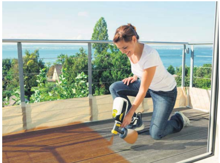
Mit einem Sprühsystem lässt sich der Wetterschutz schnell und sauber erneuern. Foto: djd/J. Wagner
